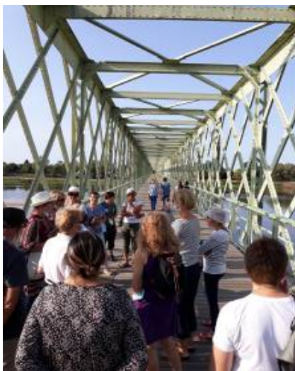
Ancien pont de chemin de fer
